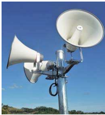
設置された屋外スピーカー
